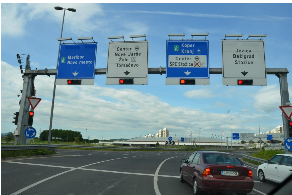
Obr. 47. Slovinsko - Ljubljana - světelně řízená turbo-okružní křižovatka.
