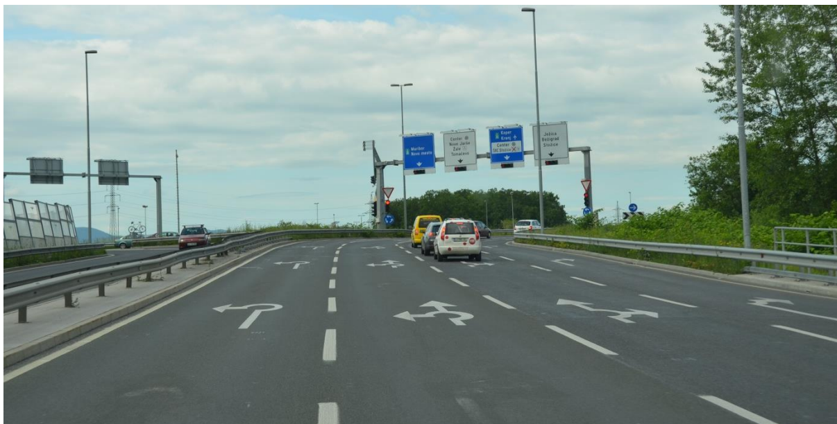
Obr. 46. Slovinsko – Ljubljana – světelně řízená turbo-okružní křižovatka.
