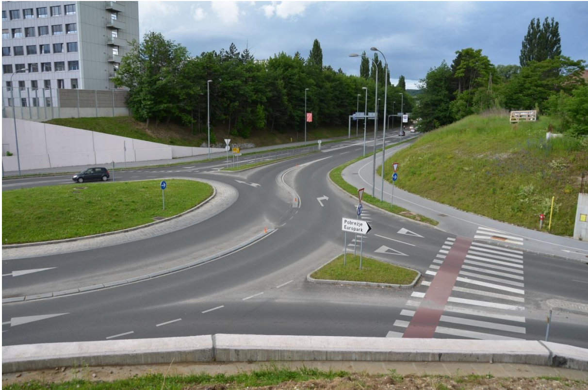
Obr. 50. Slovinsko – Maribor – turbo-okružní křižovatka s fyzickým oddělením jízdních pruhů v letním období.
