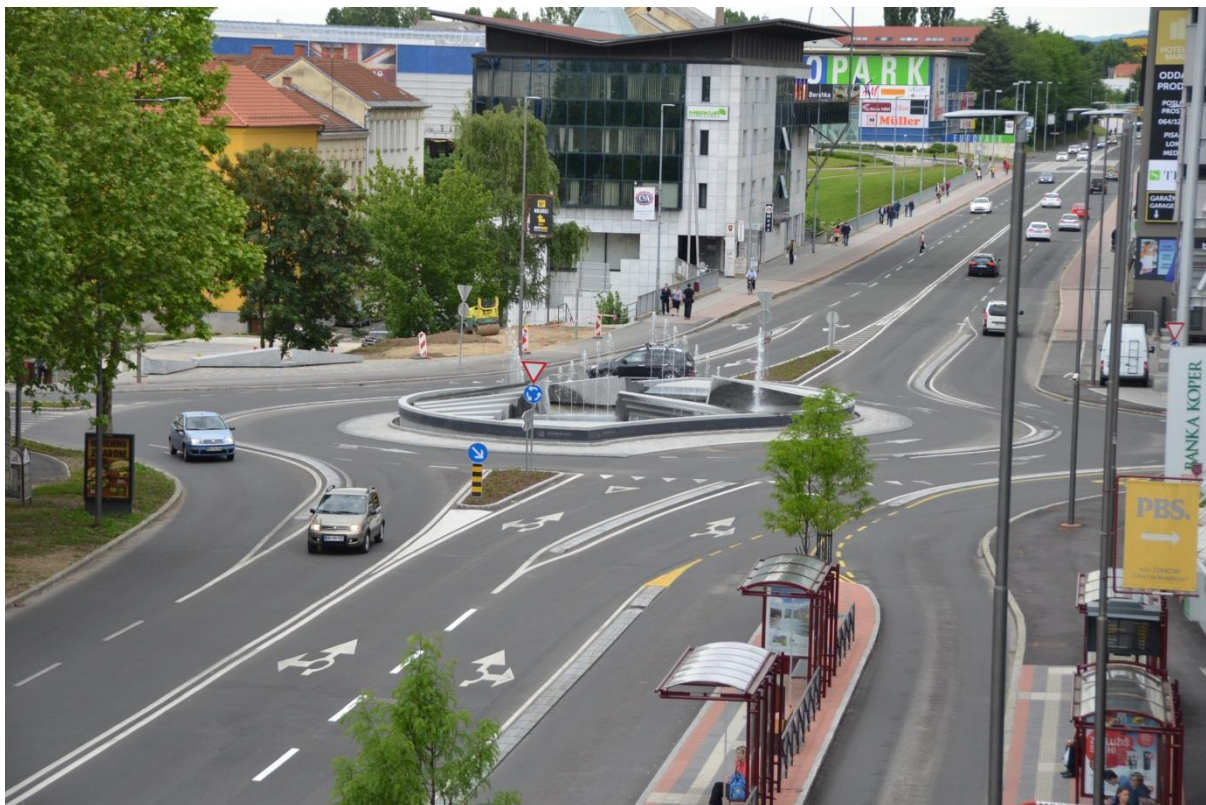
Obr. 48. Slovinsko – Maribor – turbo-okružní křižovatka v intravilánu.
