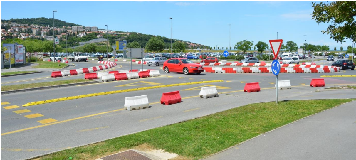
Obr. 43. Slovinsko – Koper – provizorní turbo-okružní křižovatka.
